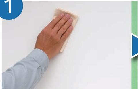
塗布面を平滑にするために、ペーパー等で洗浄して下さい。水分を除去し、ブース内を完全に乾燥してください。
