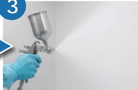
スプレーガン等で塗布して下さい。乾燥後、表面にコーティング膜が形成されます。
